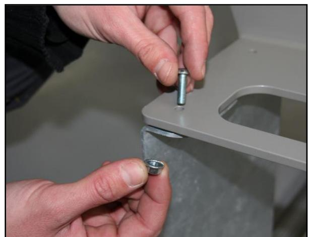
5. **Serrer la visserie du rack** à l'aide d'une clé allen n°4 et d'une clé plate n°10.
