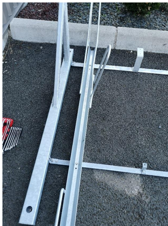
VIS DANS TROUS TARRAUDE ATTENTION BIEN FIXER DANS LES TROUS ENTOURE EN ROUGE
